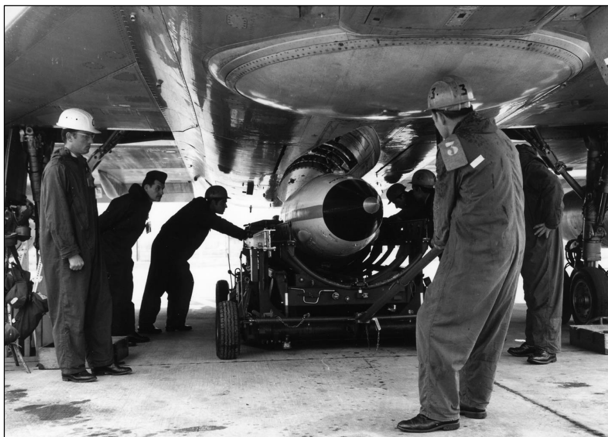
Crédit Photo ECPAD. Une équipe de mécaniciens nucléaires procédant à la mise en place d'une maquette de bombe AN 21 sous un Mirage IV A
