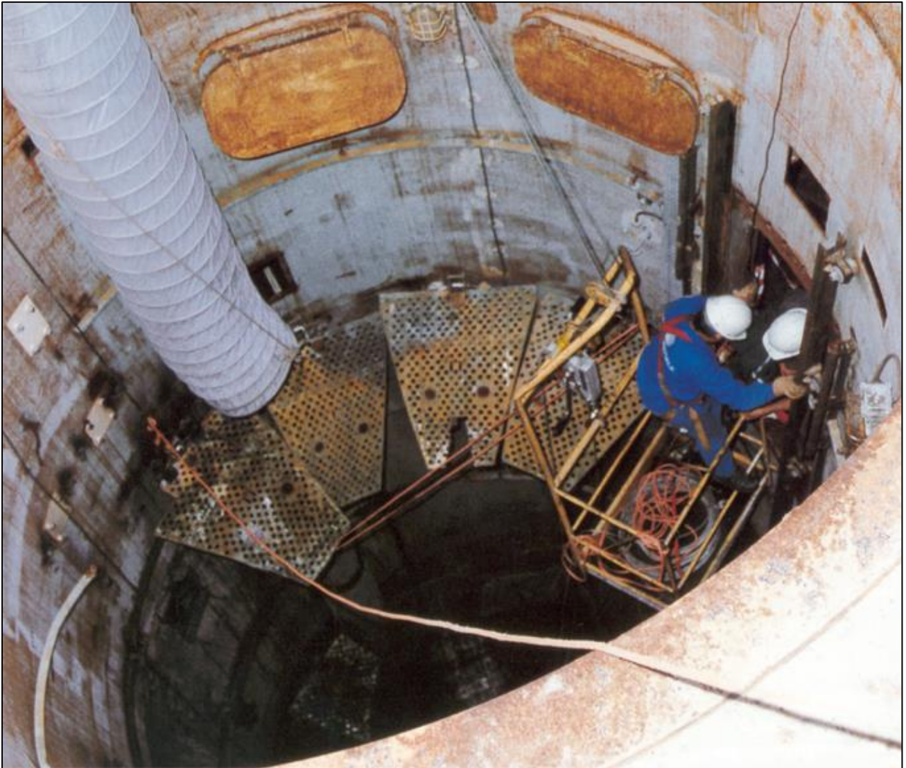
Photo DR/CFAS : Opérations de démantèlement d'un silo dans une zone de lancement, conséquence de la décision de l'arrêt de la composante balistique stratégique du Plateau d'Albion prise par le président Jacques Chirac lors du conseil de défense du 22 février 1996.
