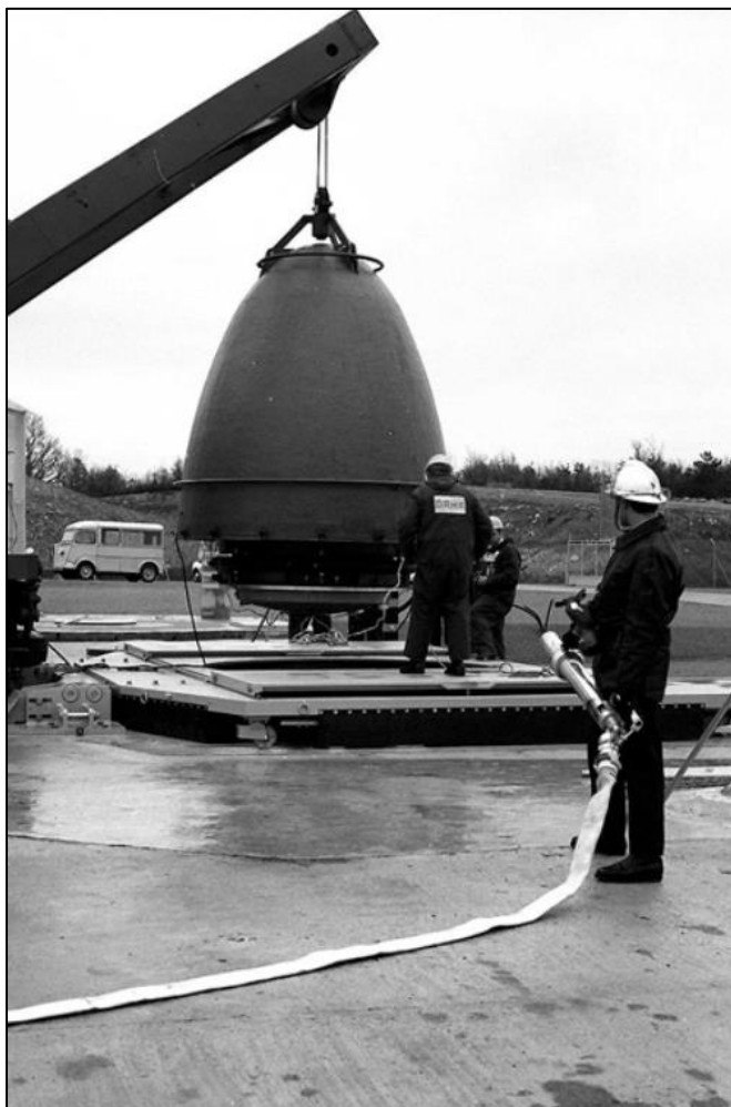
Photo DR/CFAS : Un conteneur renfermant la tête nucléaire d'un SSBS S3 sur le point d'être progressivement abaissé pour être positionné sur corps du missile dans son silo.
