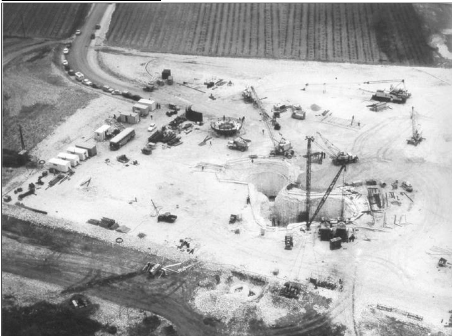
Photo DR/CFAS : Un chantier de construction d'une zone de lancement pour le futur groupement de missiles stratégiques.
