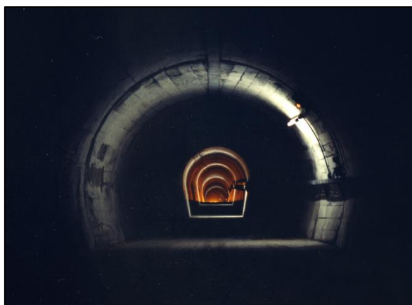
Photo DR/CFAS : Vue d'un tunnel dans un PCT.
